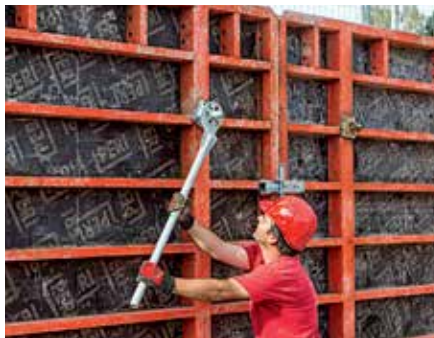
A szárnyasanya kulcs lehetővé teszi a különböző szárnyasanyák kalapács nélküli egyszerű meghúzását és oldását. Különösen időtakarékos megoldás ez a felső átkötéseknél.
