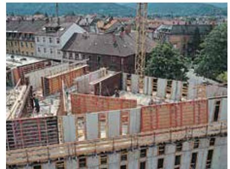
A TRIO Struktur standard TRIO elemekkel kombinálható. Ez nagy előny, mivel speciális felületek gyakran csak egy oldalon szükségesek.
