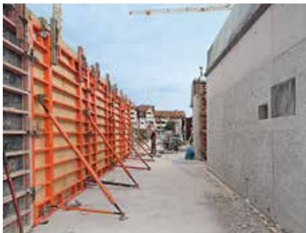
A TRIO Struktur egy közkedvelt zsalurendszer egyik változata, bármilyen TRIO kiegészítővel kompatibilis.
