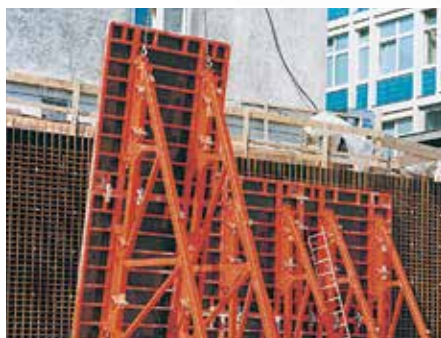
A teherbíró kapcsolat lehetővé teszi a komplett egységként történő áthelyezést.
