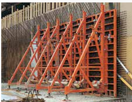
SB-B és SB-C támbak egységek TRIO keretvázazsaluzattal kombinálva; betonozási magasság 3,50 m.
