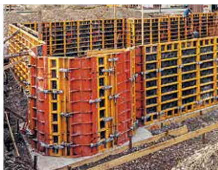
ATRIO Alu – darufüggetlen, könnyű, kézzel mozgatható alternatívát jelent.
