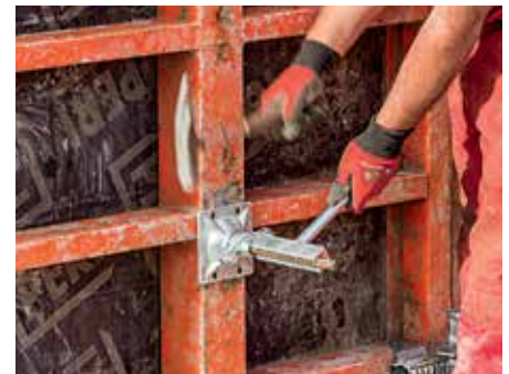
A feszítőacél kulcs megkönnyíti a feszítőacélok használatát.
