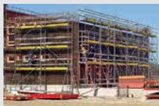
Állványok betonacél szereléshez
