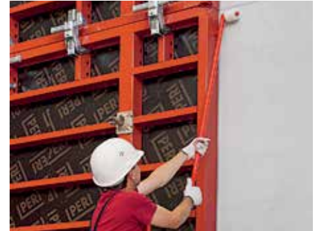
A kizsaluzó kar segítségével az elemek könnyebben és sérülésmentesen bonthatók. Görgők segítenek elkerülni a sérüléseket a betonfalon.
