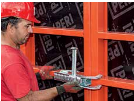
A BFD kapocs egy kézzel is könnyen használható.
