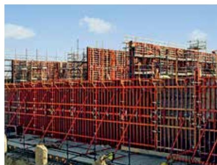
A TRIO 5,40 m magasságig 30 cm-es raszterben bővíthető. Nagyobb magasságok esetén kiegyenlítő heveder alkalmazása szükséges.
