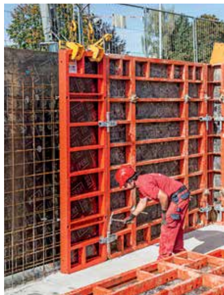
A 72 cm széles variábilis elem külső sarkokhoz és egyenes falakhoz is használható.
