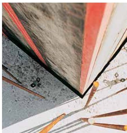
A kb. 3 cm-es kiszaluzási játék tisztán látható. A belső zsaluzat a jobb vezetés érdekében közel marad a betonhoz.
