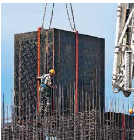
A belső zsaluzat emeléskor minden oldalon 3 cm kiszaluzási játék keletkezik, ezáltal a teljes egység egyetlen daruemeléssel áthelyezhető.
