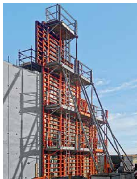
Munkaszintekkel kiegészítve a TRIO maximális biztonságot nyújt az építkezéseken. Komplet, nagy méretű mozgatható egységek, munkaszinttel, feljáróval, védőkorláttal ellátva.
