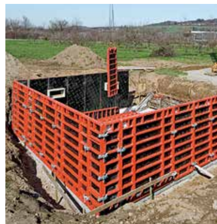
A kevés különböző rendszerelem, és az univerzális, egy kézzel kezelhető BFD kapocs teszi a TRIO-val történő zsaluzást egyszerűvé és gyorsá.
