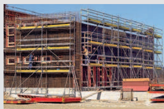
Állványok betonacél szereléshez
