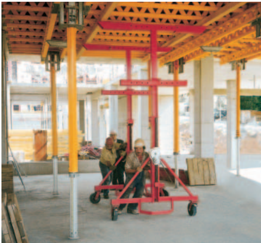
Asztaláthelyező kocsi Toldó végelem 100 alkalmazásával.
