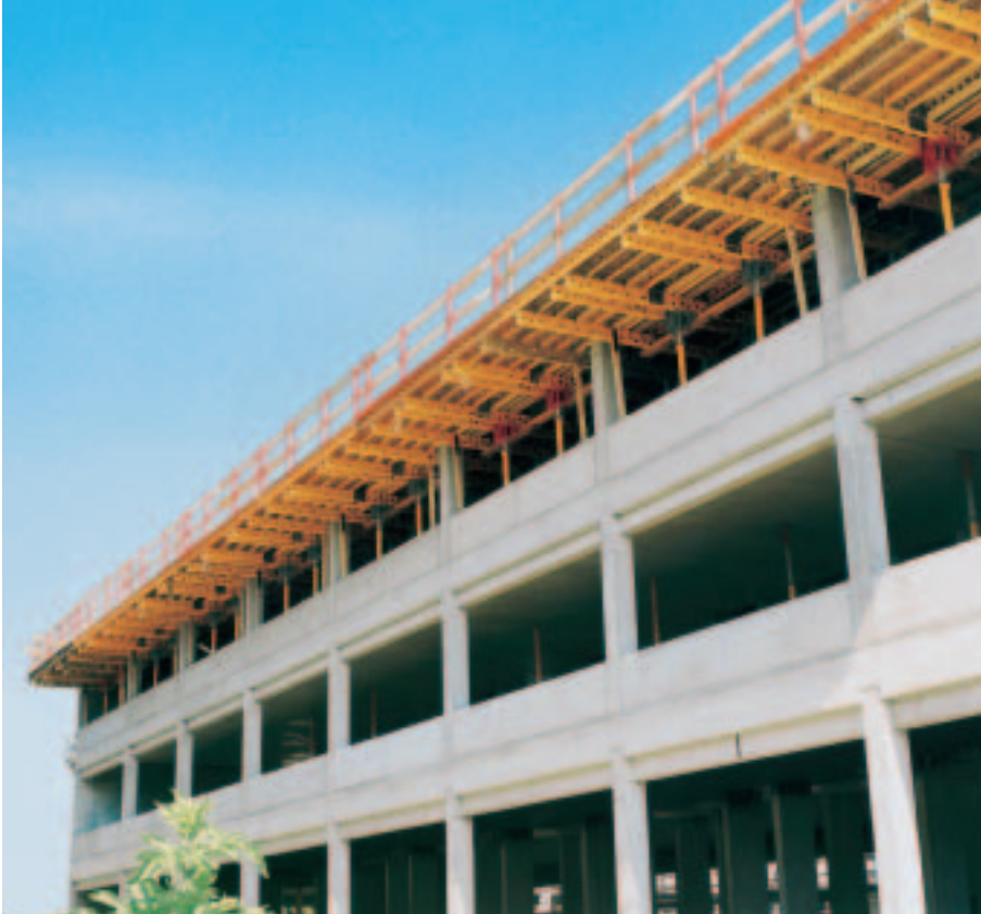
UNIPORTAL födémszél asztal konzolos kiugrással és lezuhanás elleni védelemmel.
