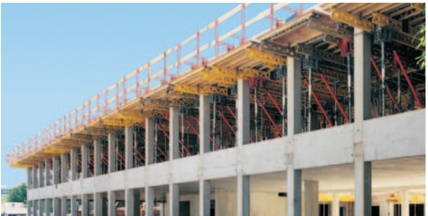
Méretre szabott födém-szél asztalok egy irodaépület építésénél.
