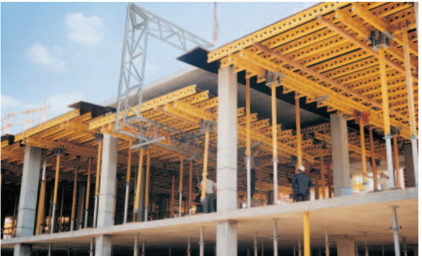
5,40 m széles és 700 m hosszú UNIPORTAL födémasztalok.
