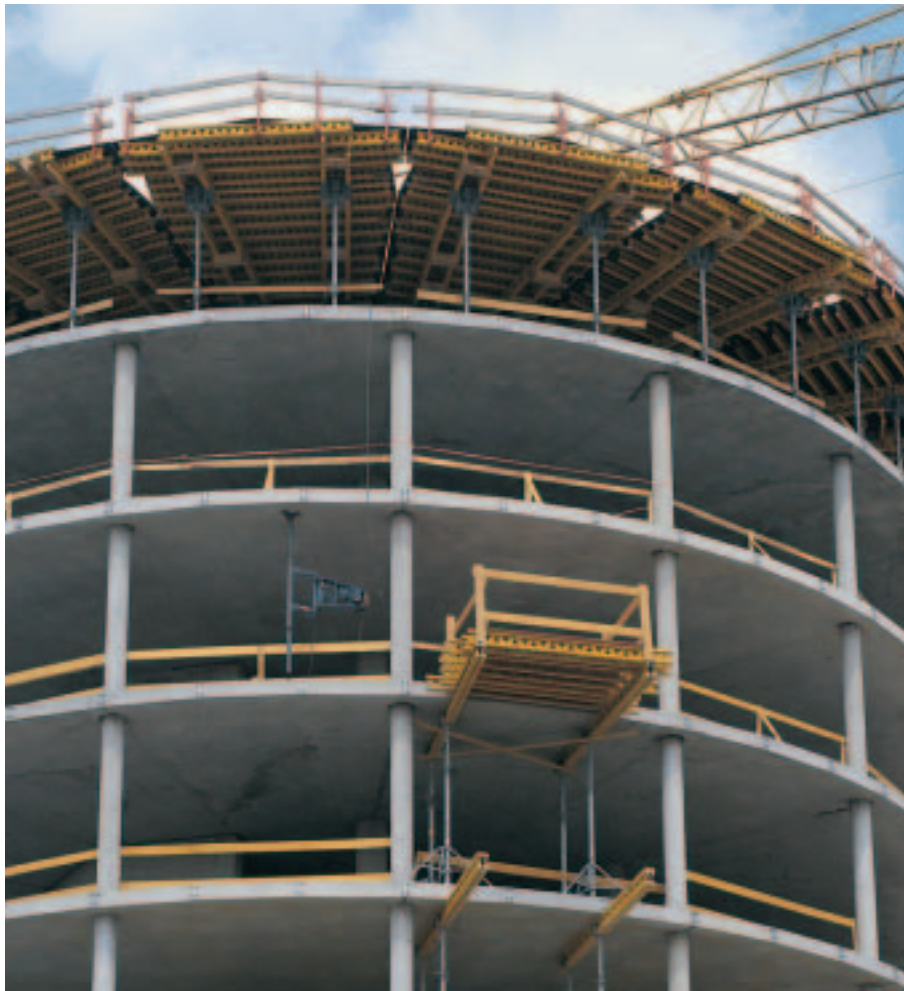
Trapéz alakú asztal egy kör alaprajzú irodaépületnél. Asztalméret: 7,00 x 4,65/2,50 m.
