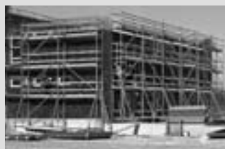
Állványok betonacél szereléséhez
