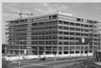
Homlokzati munkaállványok
