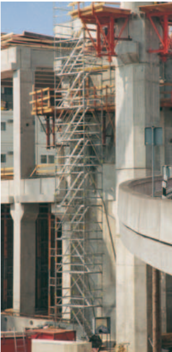
18 m magas PERI UP Rosett egykarú lépcsőtorny egy irodaház építésénél.
