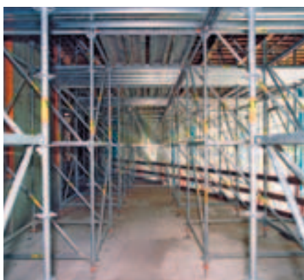
A PERI UP teherhordó állvány 1,50 m x 1,50 m-es szabvány alaprajzi raszterű tágas munkaterületet és közlekedési útvonalat biztosít a beépített munkaszintek alatt.
