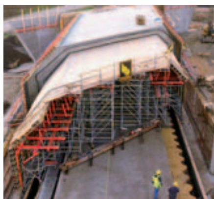
Húzás Teherhordó és csavarodásbiztos PERI VARIO GT 24 és PERI UP Rosett zsalu- és állványegységek – húzása hidraulikusan, a következő betonozási üzemhez.
