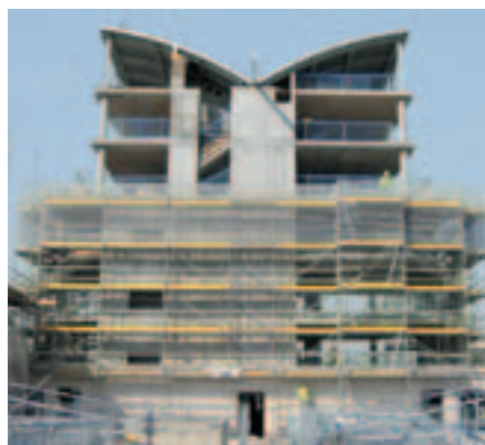
Homlokzati állvány
