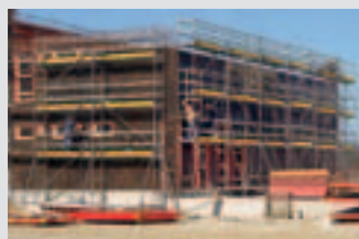
Állványok betonacél szereléshez
