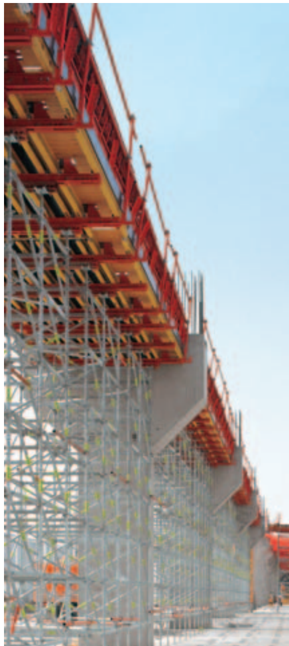
Egy repülőtér csomagleadási csarnokának 72 m hosszú tartógerendái áthelyezhető födémzsaluzat egységekkel zsaluzva.
