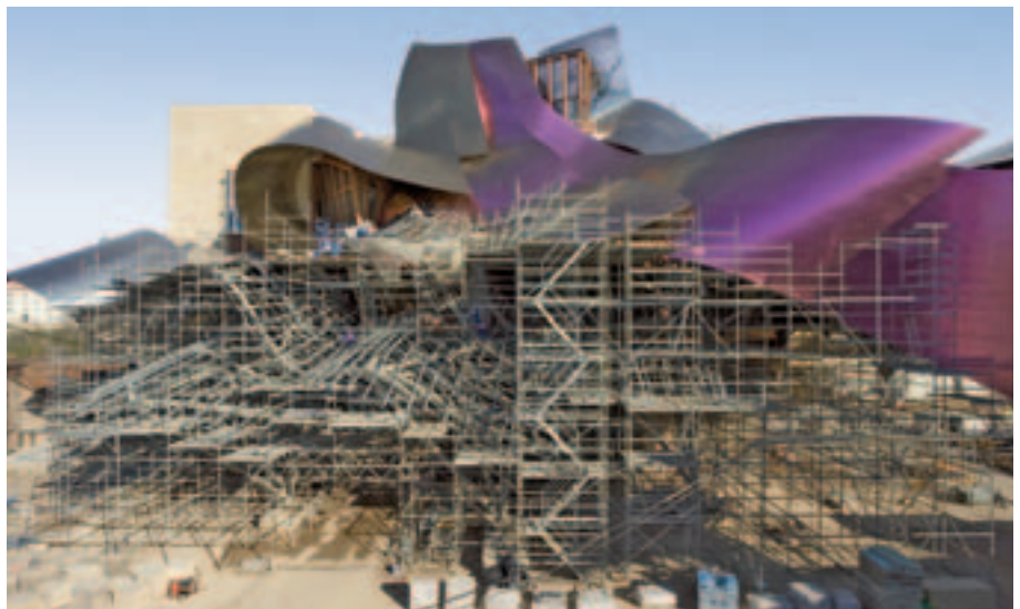
PERI UP szerelő állványok lépcsőfeljáróval egy bonyolult tetőszerkezet építésénél.
