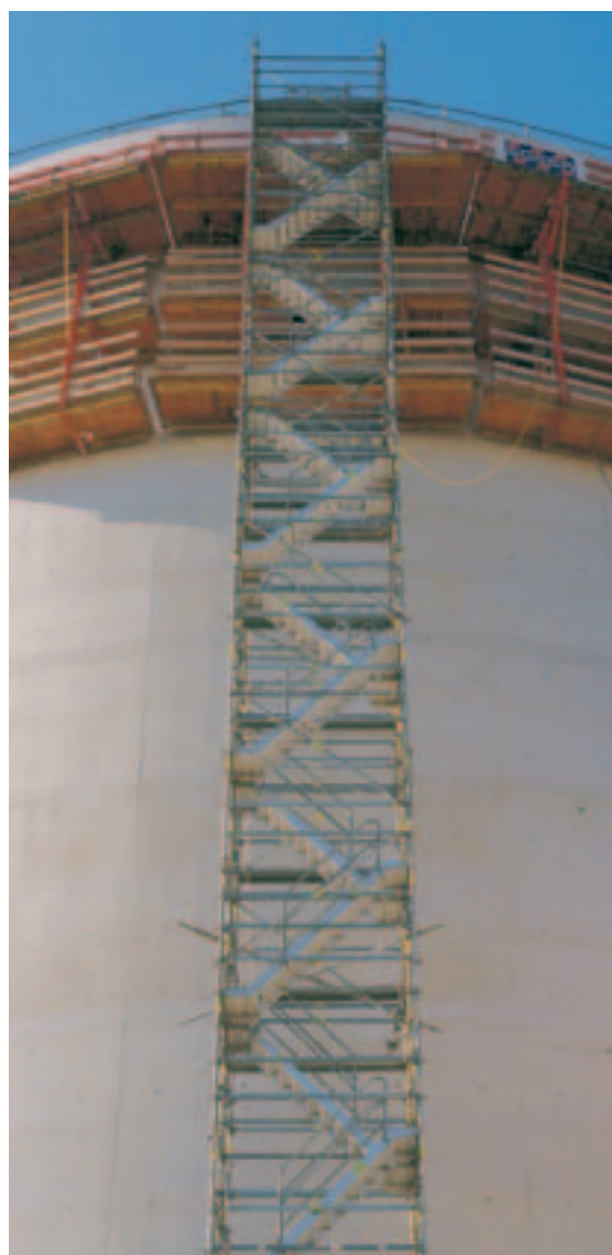
50 m magas PERI UP Rosett kétkarú lépcsőtorny egy siló építésénél.
