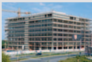
Homlokzati munkaállványok
