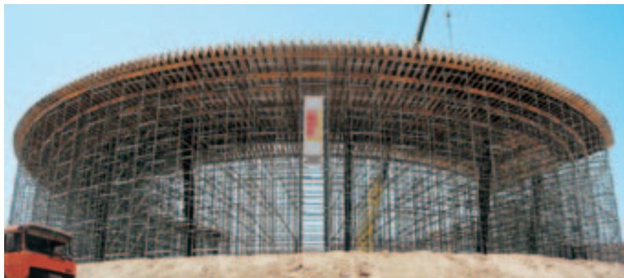
11 m magas teherhordó állvány egy 50 m átmérőjű betongyűrűhöz.
