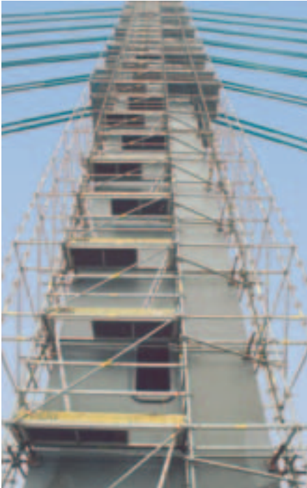
Hídylon állvány PERI UP állványok feszítőkábel szereléshez.
