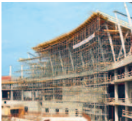
A PERI UP teherhordó állvány akár 38 m-ig is tökéletesen alkalmazható MULTIFLEX fatartós födémzsaluzathoz.
