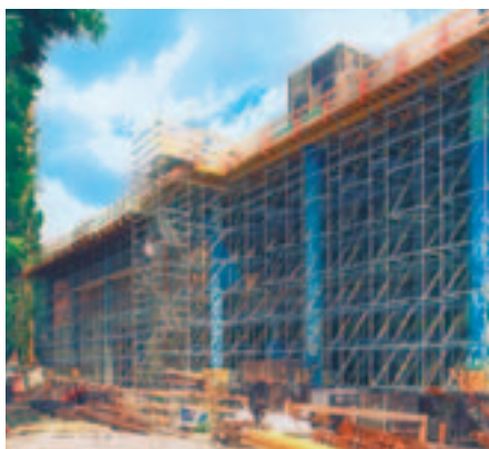
14 m magas PERI UP alkalmazása teherhordó tárcsaszerkezetként, MULTIFLEX fatartós födémzsaluzathoz. A magasan lévő munkaszintek a PERI UP lépcsőtornyoknak köszönhetően biztonságosan és gyorsan elérhetők.
