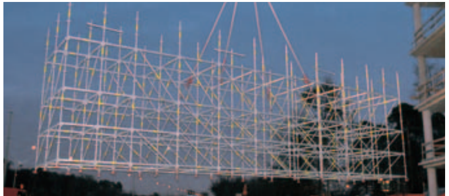
Áthelyezés daruval Egy 15 m hosszú állványegység gyors áthelyezése.
