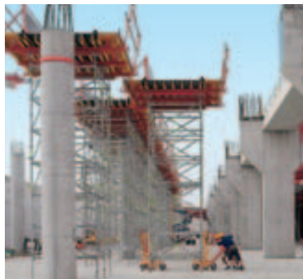
Mozgatás Teherhordó állvány daru nélküli áthelyezése komplett zsaluegységgel és munkaállvánnyal egy gerenda zsaluzásához, PERI emelő- és mozgó kocsival.
