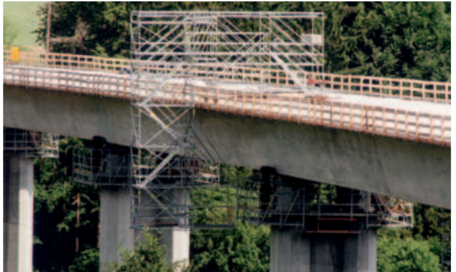
Mozgatható PERI UP függesztett állvány Pillérfejek gazdaságos elérése.
