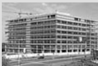
Homlokzati munkaállványok
