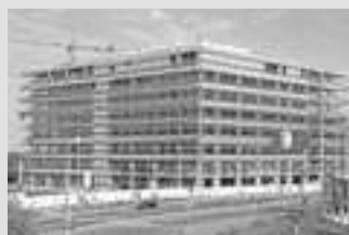
Homlokzati munkaállványok
