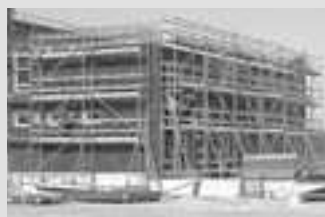
Állványok betonacél szereléshez
