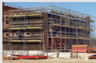
Állványok betonacél szereléshez
