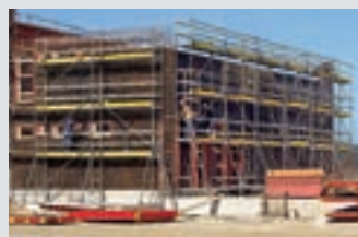
Állványok betonacél szereléshez
