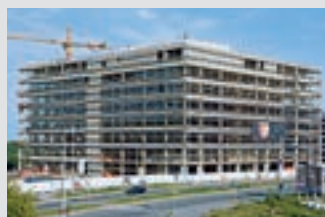
Homlokzati munkaállványok
