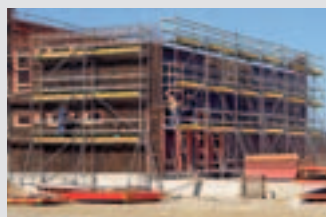
Állványok betonacél szereléshez
