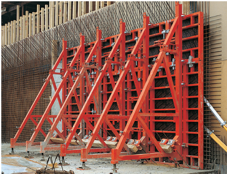
SB-B és C támbakok TRIO keretváz zsaluval együtt, betonozási magasság 3,90 m.
