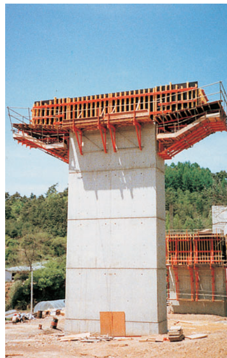
PERI SB-2 támbak a pillérfej-zsaluzat alátámasztó szerkezeteként.
