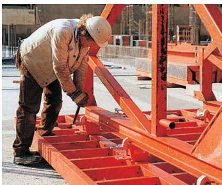
Az SB-A0, A, B, C támbakoknál az erőbevezetés minden ponton biztosított.
