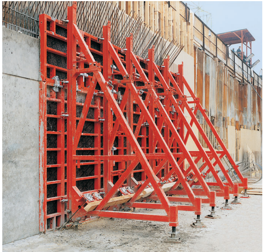
SB-A és SB-B támbak-egységek PERI TRIO keretvázaz zsaluval kombinálva, betonozási magasság 3,50 m.
