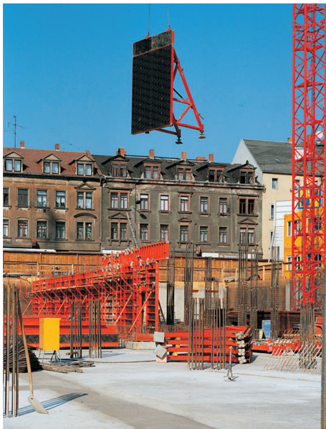
SB-B és C egyoldali támbakok TRIO keretes zsaluval, teljesen áthelyezhető egységként.
