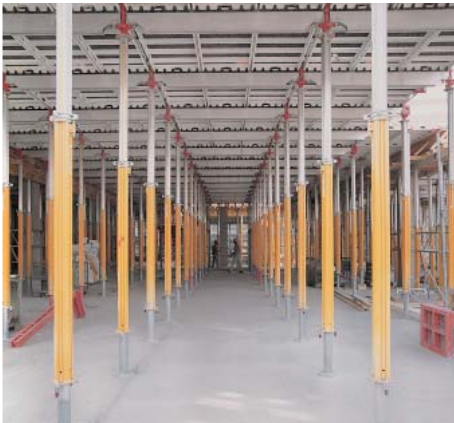
MULTIPROP 350 támaszok és MULTIPROP MP 50 lábak SKYDECK födémzsaluval egy 4,10 m belmagasságú födém zsaluzásakor.
