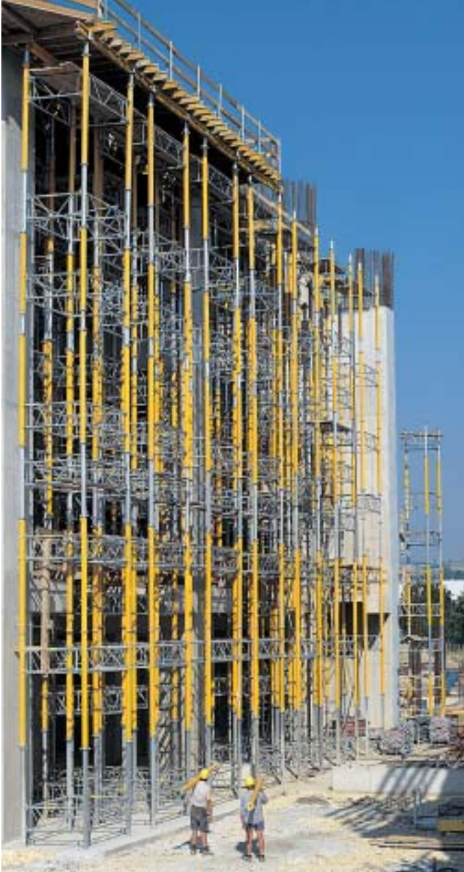
20 m magas MULTIPROP tornyok egy kinyúló födémzsaluzat alátámasztásához.
