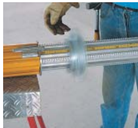
Egyetlen fordulattal 36 mm-es hossz állítható. (3-szor hosszabb, mint a hagyományos födém támaszoknál)
