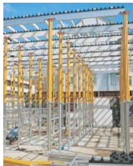
A MULTIPROP támaszok szükséges állékonysága nagy kihúzási hosszánál MRK keretek alkalmazásával is biztosítható.
