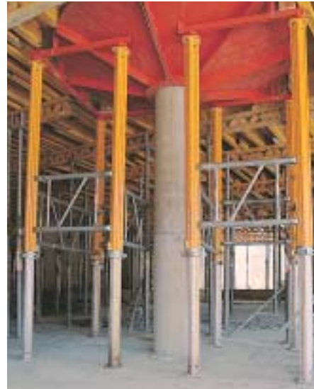
20 m magas MULTIPROP tornyok egy kinyúló födémzsaluzat alátámasztásához.
