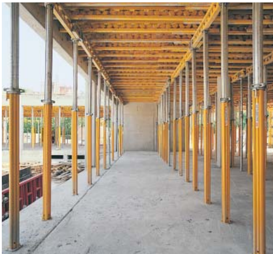
MULTIPROP 350 MULTIFLEX földémszaluzattal
