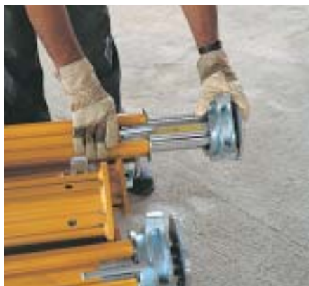
A beépített mérőszalag minden MULTIPROP támasz alaptartozéka.
