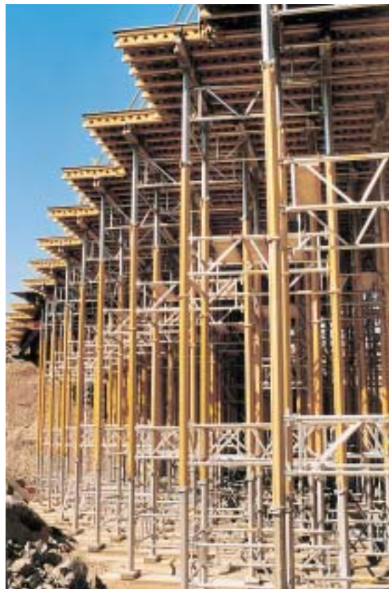
8,80 m magas MULTIPROP tornyok asztalszalu alátámasztásaként.
