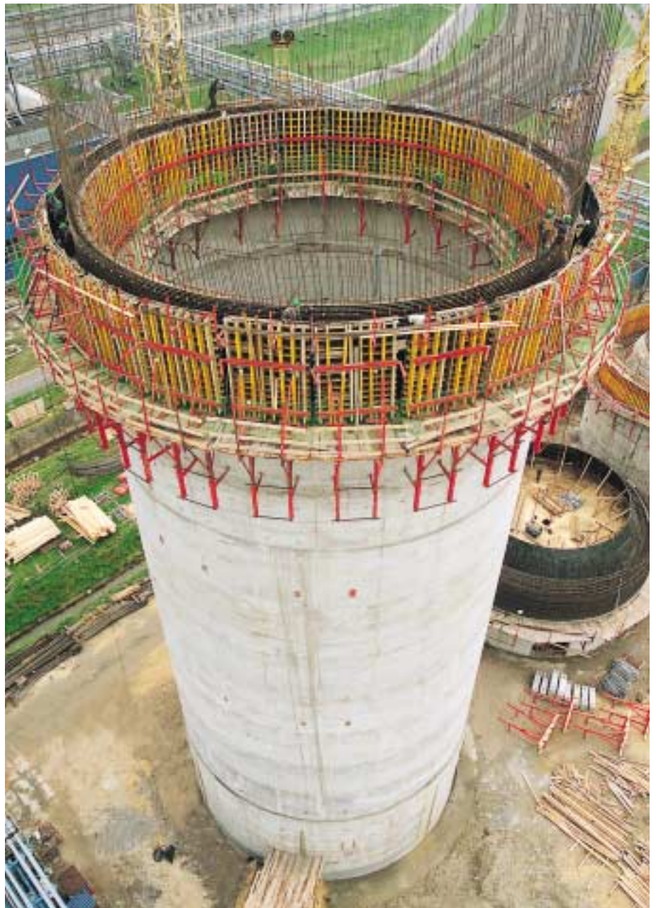
72 m magas és 20 m átmérőjű pernye siló az opolei erőműnél, Lengyelországban. KGF kúszó állványra szerelt VARIO íves fatartós zsaluval zsaluzva.
