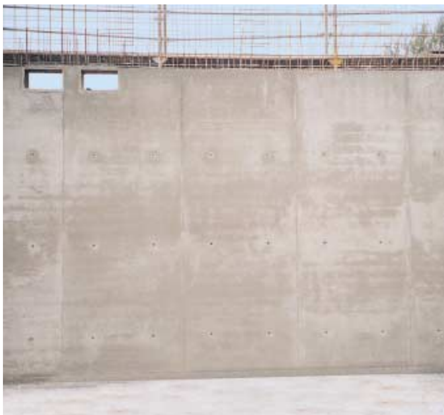
Rendezett 0,75 x 1,18-as átkötési rasztér és sima felületű látszóbeton az eredmény. Középiskolai központ Kletow-ban.
