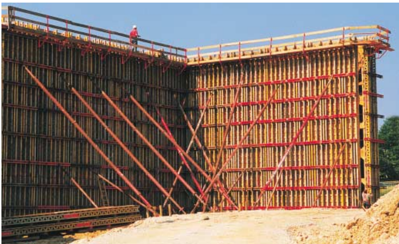
11,00 m magas hídfő készítése magasított, és kiegészítő, merevítést adó átlapoló fatartókkal.
