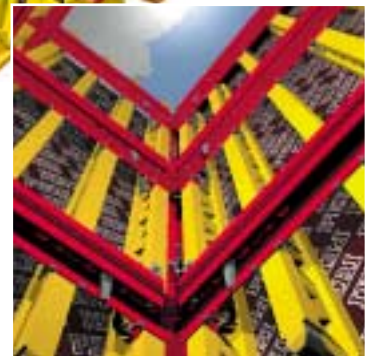
Kisméretű liftakna kereszt-hevederrel és SSE sarokzsaluzóval.
