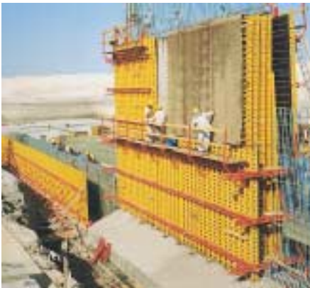
A VARIO GT 24 alkalmazása egy koreai szennyvíztisztító telep építésénél – kónuszosan karcsúsodó falakkal.
