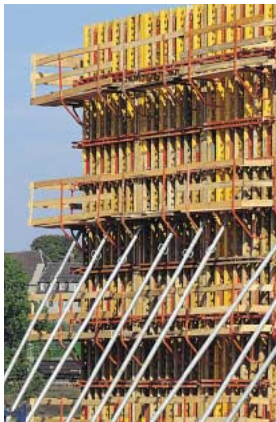
Készre szerelt VARIO elem: Tartozékai: faltámaszok, merevítők és betonozó állvány.
