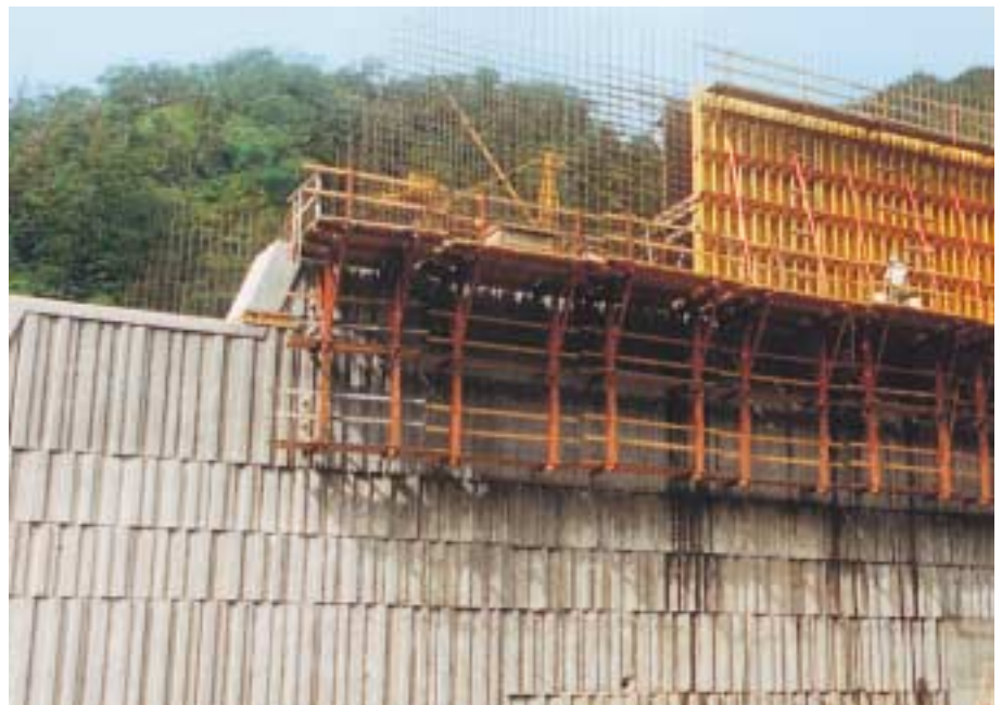
Alagút építmény portálja Hawaii-n. VARIO GT 24-el KGF 240 kúszóállványról zsaluzva.
