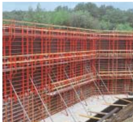
A TRIO alkalmazása ipari építkezésen
