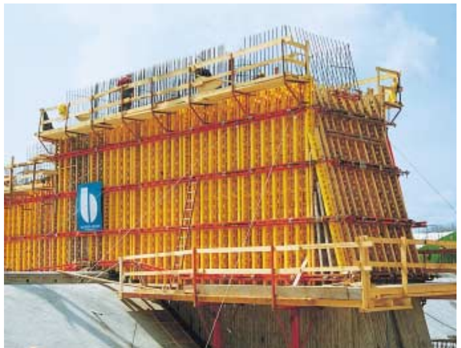
A duzzasztómű pillér hátsó oldala. A VARIO GT 24 itt egyszerűvé tette a ferde hátfalhoz igazodó beállítást.
