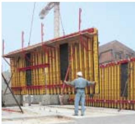
A VARIO GT 24 alkalmazása lakásépítésnél
