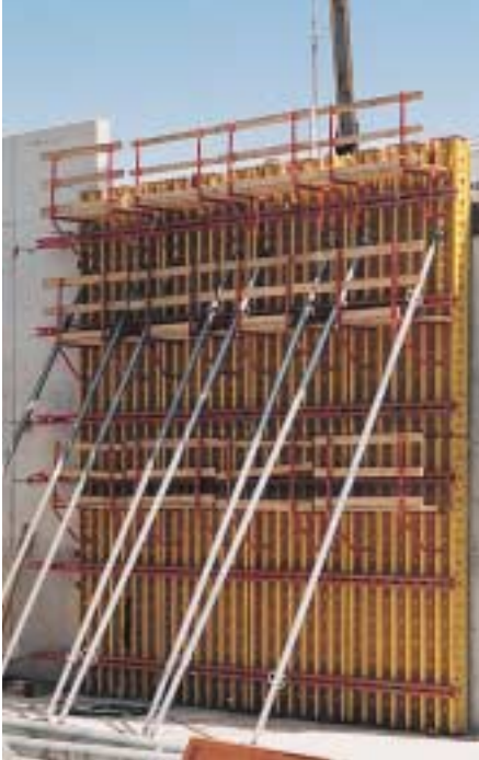
Magasított VARIO elemek egy irodaház építkezésén. (ld. 26. oldalt a magasításról)
