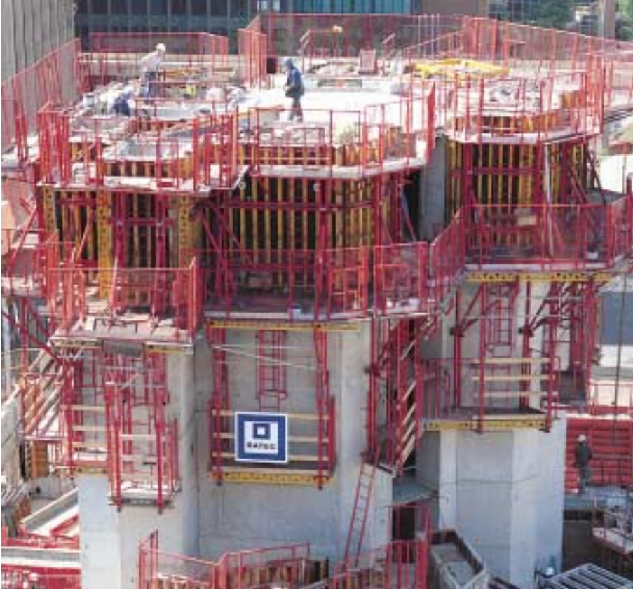
Párizsi magasház építése VARIO GT 24 rendszerrel és CB 240-es kúszóállvánnyal.
