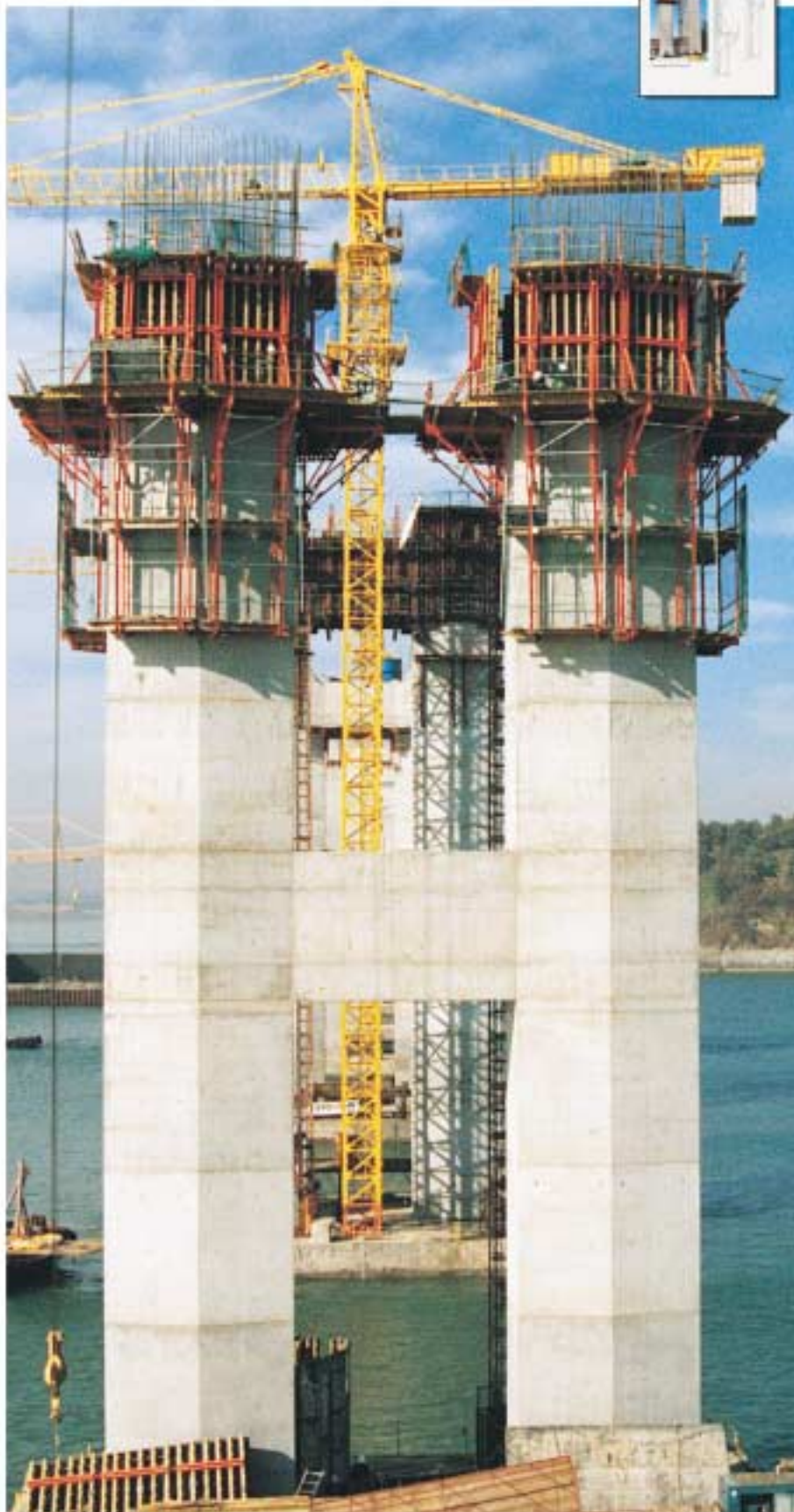
A CB 240 háromszög-konzol a zsaluzat előtt és mögött is problémamentes munkavégzést tesz lehetővé.
