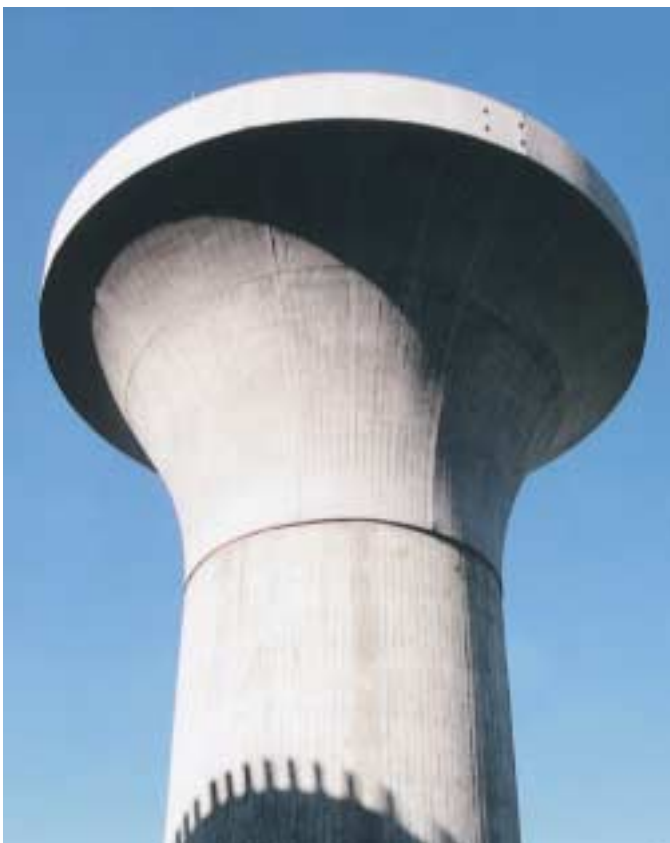
A Triebisch patak feletti völgyhíd. A max. 49 m magas pillérek trombitaformájú pillérfejekkel készültek.
