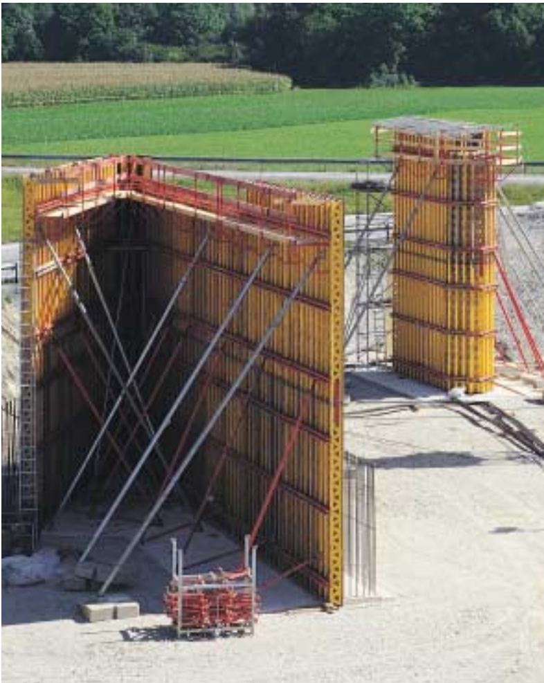
Hídfők és pillérek a VARIO GT 24-el zsaluzva. Vasúti kereszteződés építése az új müncheni repülőtérhez.
