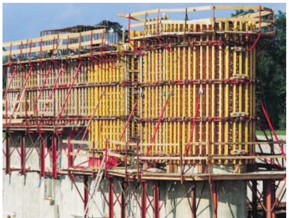
A duzzasztómű pillér első oldala. A VARIO-t GRV íves zsalurendszerrel együtt alkalmazták KGF 240-es kúszó állványon.
