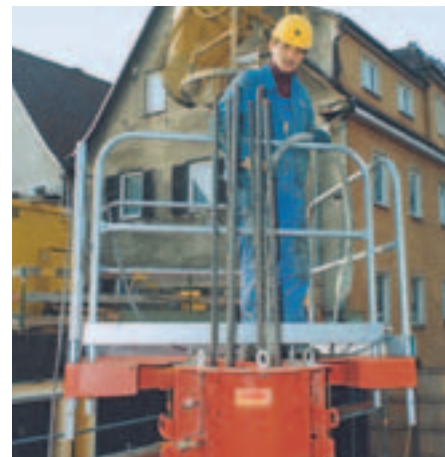
A betonozó állványon minden magasságban biztonságos a munkavégzés.
