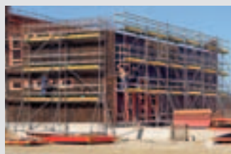
Állványok betonacél szereléshez
