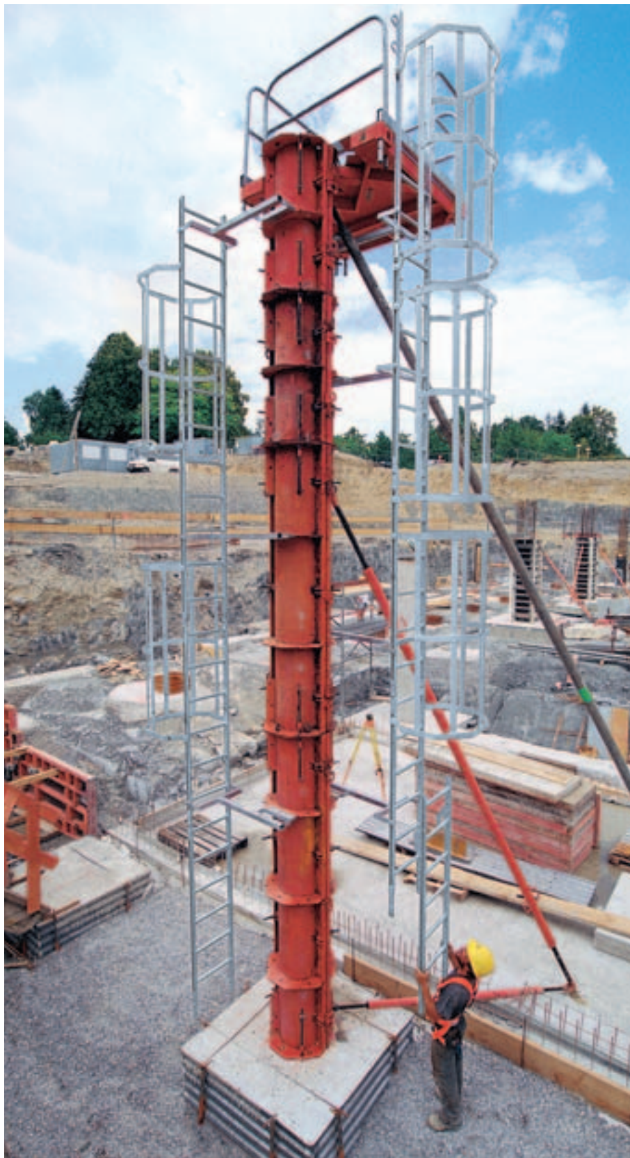
A betonozó állványon minden magasságban biztonságos a munkavégzés.
